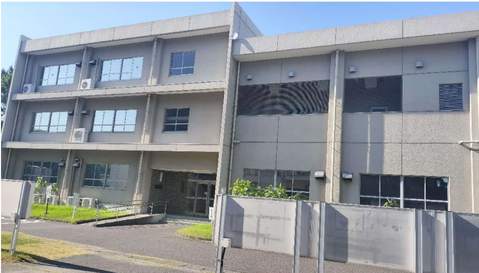
【画像】 水産学部 4 号館建物外観
