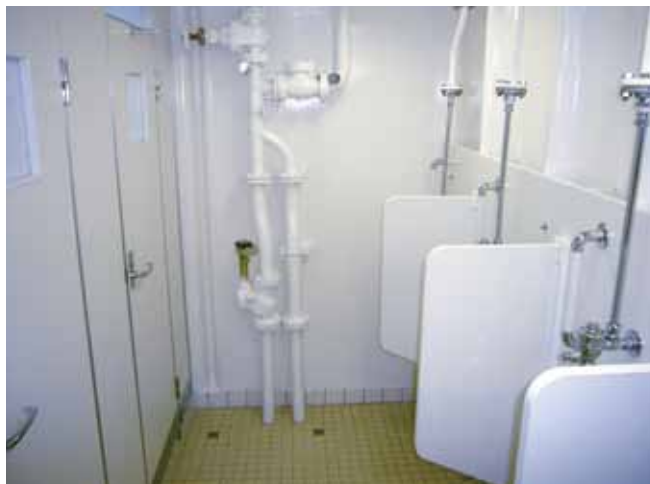
乗組員衛生室 CREW'S SANITARY SPACE
