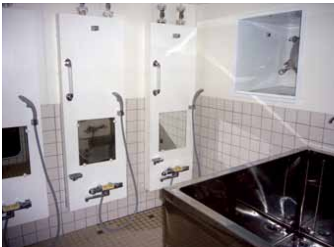
乗組員浴室 CREW'S BATH ROOM
