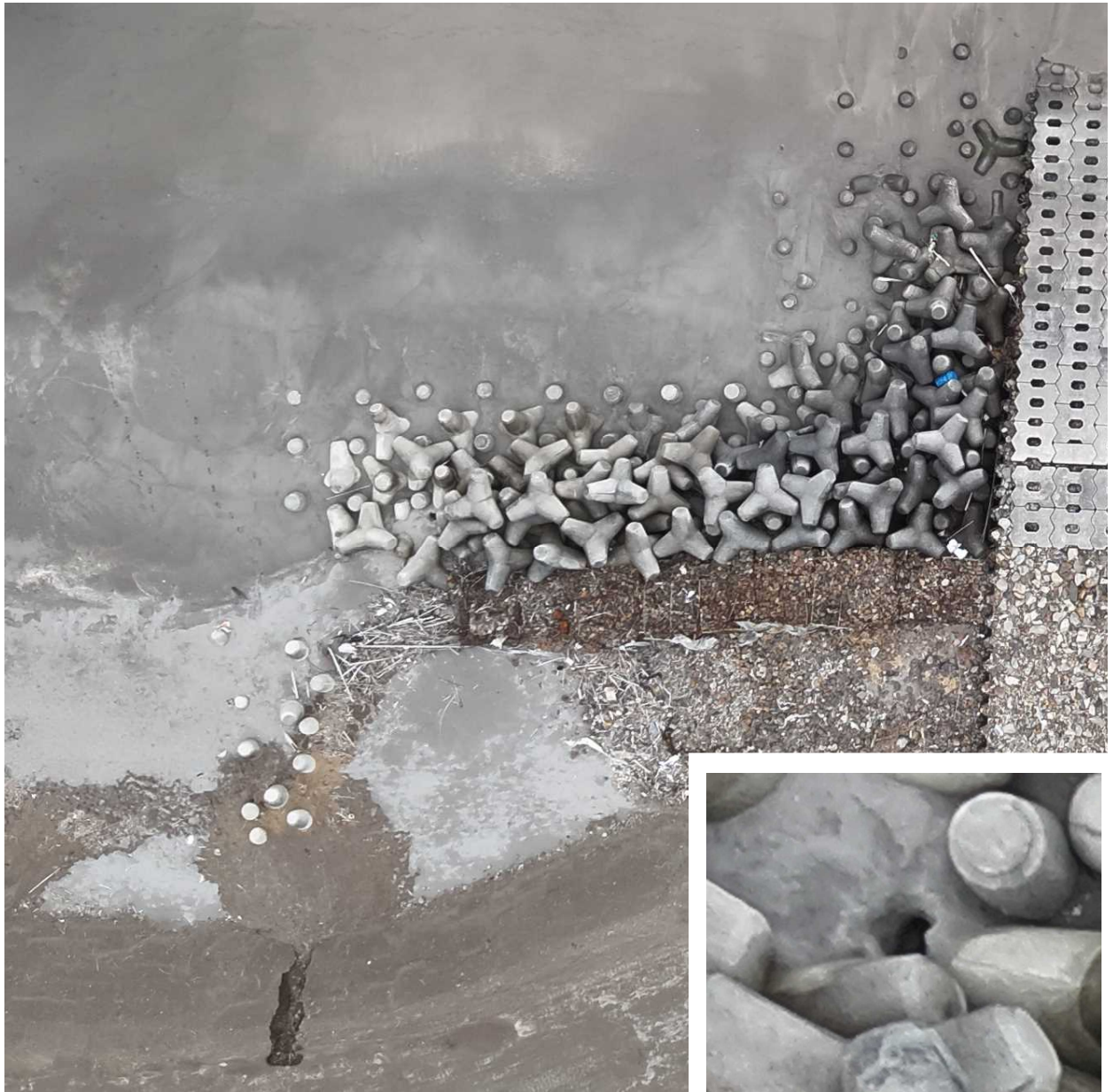
写真-1.6 消波ブロックの間に形成された孔
