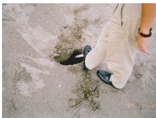
写真－1.4 砂浜を踏み抜いた状況
