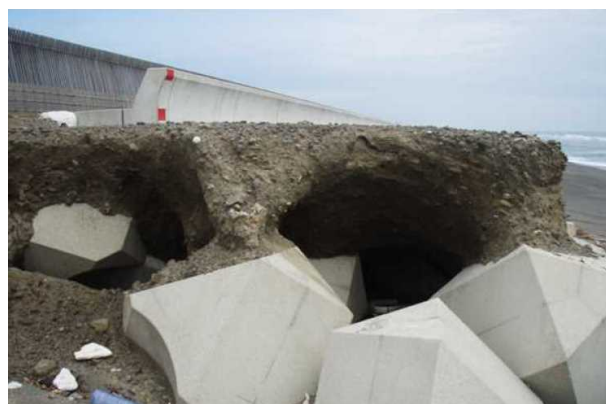
写真－1.5 構造物周辺の地下空間の断面状況
