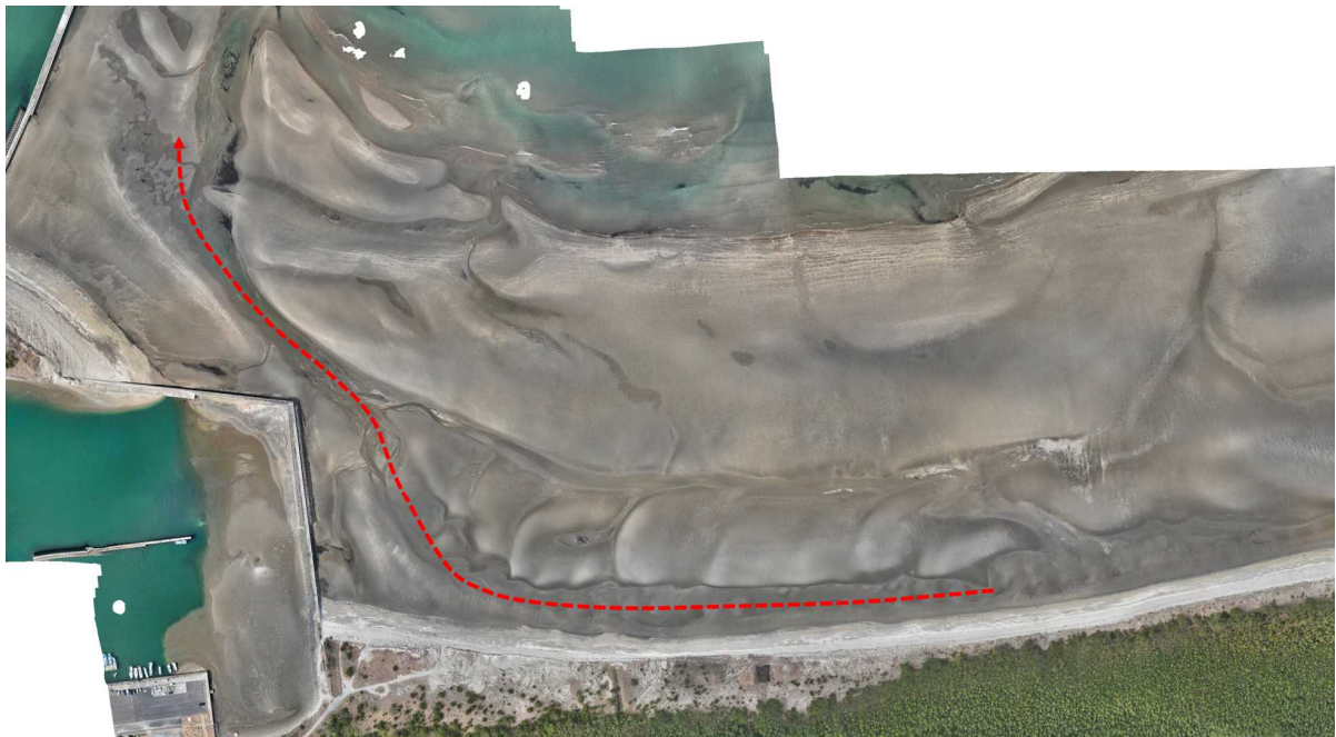
写真-29 港湾構造物周辺の海浜地形
