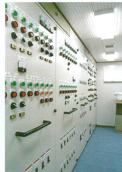
主配電盤 Main switch board
